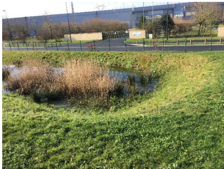
Figure 2 - Bassin végétalisé d'un îlot privé
